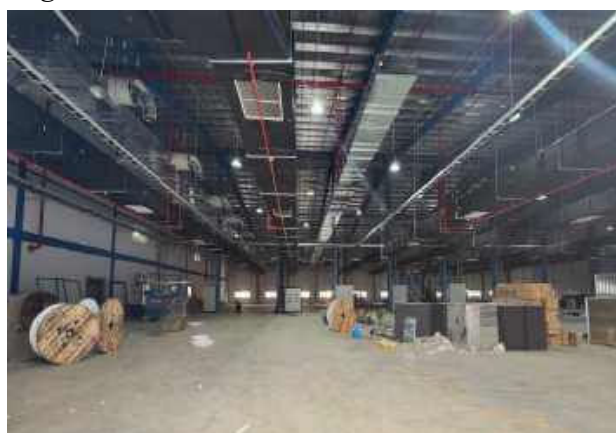
Hình 1. 3. Hiện trạng các hạng mục xây dựng của Cơ sở 2 tại thời điểm lập báo cáo
