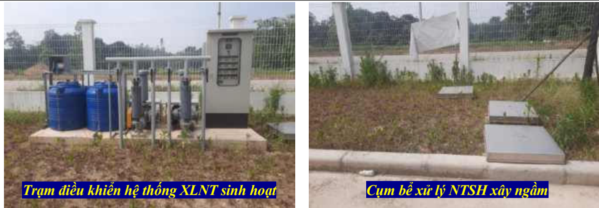
Hình 1. 34. Hệ thống XLNT sinh hoạt đã đầu tư được sử dụng cho dự án
